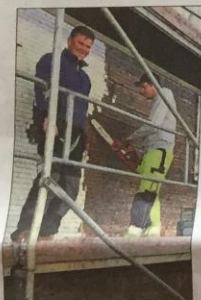
Die jungen Zimmerer entfernen Schindeln. Foto: Lieb
